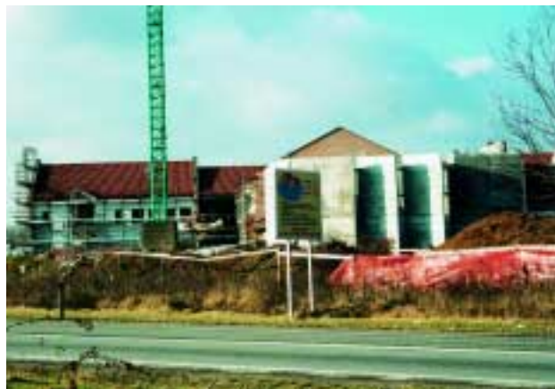
I lavori alla R.S.A.
